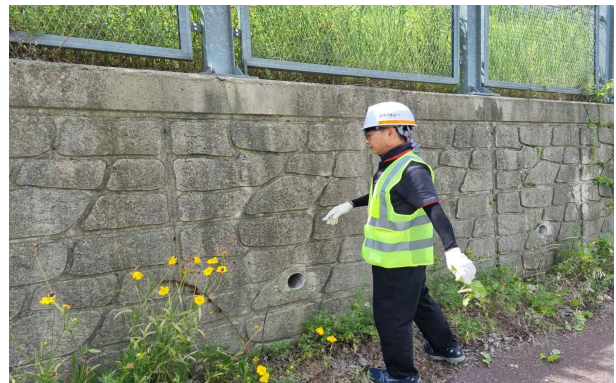
A-LINE 옹벽 점검
