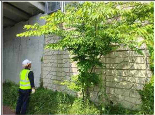
A-LINE 옹벽 점검
