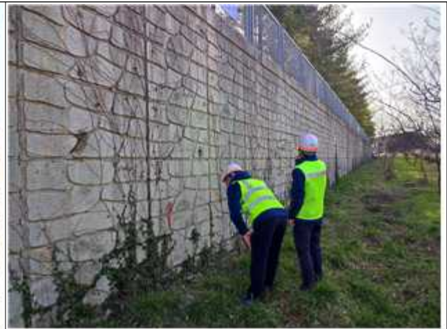
A-LINE 옹벽 점검
