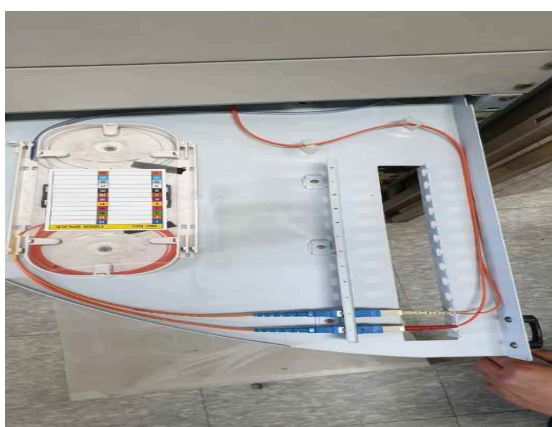
미디어컨버터 철거 후 광케이블 연결
